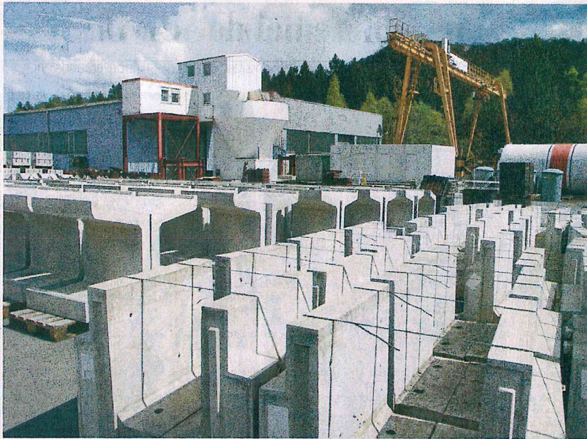
Hunderte Betonfertigteile lagern auf dem Betriebsgelände der BBL Beton GmbH. Die Mischanlage im Hintergrund wird bald erweitert, um die Produktionsstrecke für die Herstellung von weißem Beton zu verbessern. Fotos: Ciszewski
